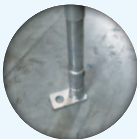
Pied pour renfort pignon télescopique à goupille
